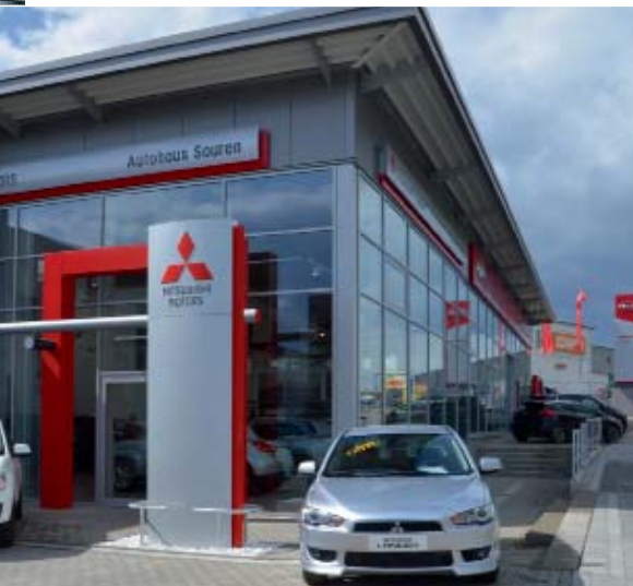
Hanglage als Chance: Trennung der beiden Marken über eine Neuwagenausstellung mit zwei Ebenen
